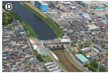
大和田機場(排水)
