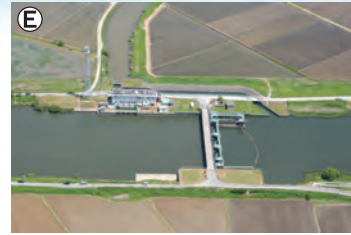
酒直機場(揚水)・酒直水門
